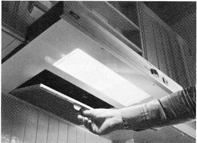
Demontering av filter.
