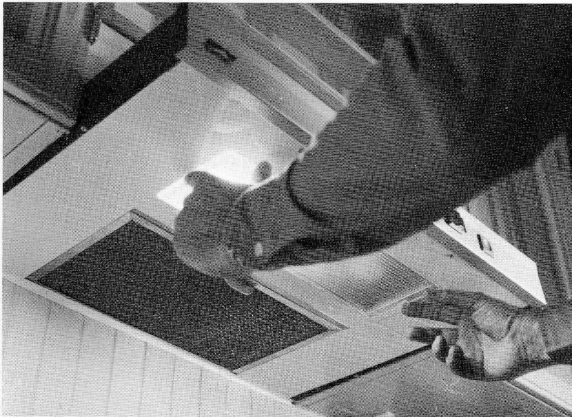
Demontering av lampglas.
